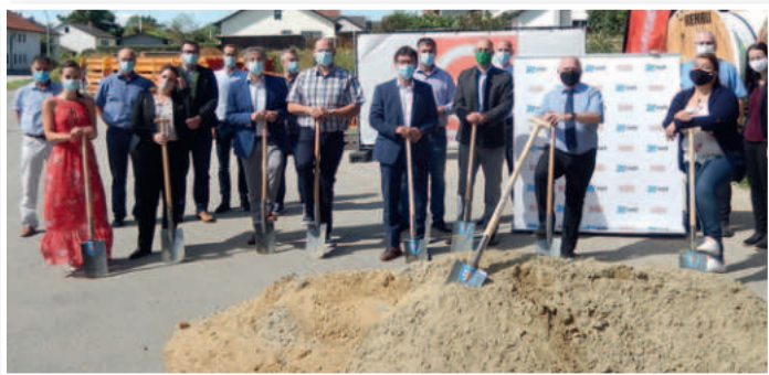
Internetausbau – Baukosten: 3,5 Mio EUR
